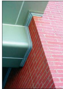
L'installation de Seismic Colorseal en façade de bâtiment entre des matériaux disparates maintient les coefficients R de l'enveloppe du bâtiment. Et parce que SEISMIC COLORSEAL ne requiert aucune attache, il convient particulièrement au jointement des angles rentrants.
