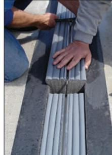
*La contre-pression de la mousse SJS et un adhésif époxydique assurent l'étanchéité avec ancrage non invasif, sans recourir à une gouttière. L'installation est plus rapide que n'importe quel autre système plus complexe.*
