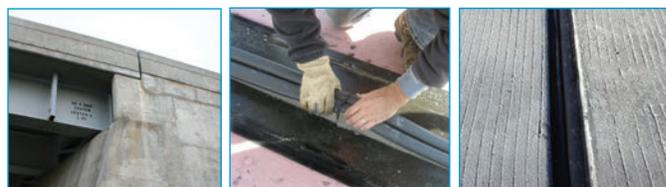
De l'identification du problème structural dans un nouvel aménagement ou la réhabilitation d'une ouverture de joint de dilatation, jusqu'à l'installation, le système BEJS offre la solution durable, rapide et abordable d'une étanchéisation continue à travers les chaussées, les bordures, les trottoirs et les parapets.
