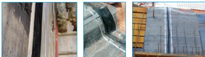
Une fois le système BG installé dans le coulis de béton ou le blindage de bois, le béton est coulé pour envelopper la membrane d'étanchéisation et le joint BG de manière à former un système étanche capable de s'ajuster aux mouvements à l'ouverture du joint.
