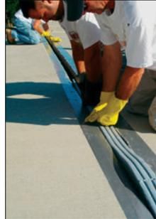
Le système DSM est facile d'installation. Après l'application d'époxy sur le substrat, des bandes de mousse DSM sont insérées dans le joint. Les bandes adjacentes sont alignées avec l'extrémité déjà en place et maintenues hors du joint jusqu'à ce que la première bande soit bien assise dans le joint, et ainsi de suite.
