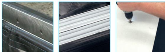
Le système SJS-FP consiste en deux sous-ensembles. L'assemblage des pattes de montage et des feuilles latérales d'étanchéité intégrées est installé sur la dalle porteuse et intégré au système d'étanchéisation du tablier. L'assemblage SJS précompressé étanche à l'eau est posé entre les longerons de l'assemblage des pattes de montage pour être ensuite surmonté d'une plaque de recouvrement en aluminium ou en acier inoxydable.
