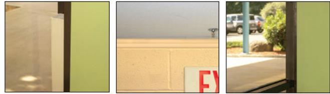
Les joints QuietJoint comblent sans difficulté les ouvertures de joint entre les cloisons, les murs et les fenêtres et ailleurs dans les aménagements sans mouvement.
