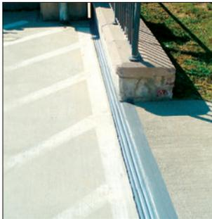
La technologie DSM offre une solution de scellement de joints structuraux. Ci-dessus, le système DSM est installé au sommet d'une rampe à la transition d'une voie carrossable sur le sol à une dalle sur appuis, de même qu'une transition de dalle à dalle et de dalle à mur.
