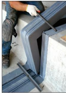
*EMSEAL offre des transitions fabriquées en usine pour les girons et contremarches faciles d'installation et qui assurent l'étanchéité aux changements de plan.*
