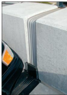
L'encochage et la flexion du coussinet de mousse permettent à la face en silicone du soufflet de demeurer continue aux changements de direction dont on sait qu'ils sont toujours difficiles à étanchéiser. Pour connaître les détails CAO sur les technologies du fabricant eu égard au jointement des matériaux disparates, prière de téléphoner chez EMSEAL ou de visiter [www.emseal.com](http://www.emseal.com).
