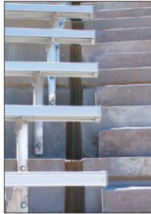
Ci-contre, l'étanchéisation des joints de dilatation dans la section des gradins en béton préfabriqué d'un stade. Le système DSM offre la continuité d'étanchéité autant dans les changements de plan que dans les changements de direction.
