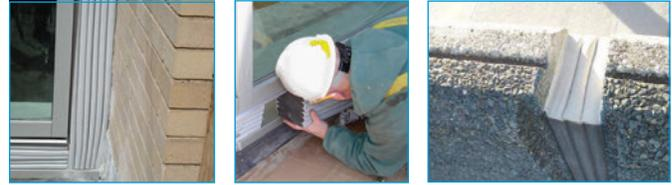
Seismic Colorseal DS scelle les joints de mur-rideau des côtés intérieur et extérieur en une seule étape d'installation. Les deux côtés peuvent être de couleur différente pour s'harmoniser avec l'agencement des couleurs intérieures et extérieures. Dans les parquets, Seismic Colorseal DS façonne des surfaces scellées sur les trois plans exposés de l'aménagement, soit le dessus, l'arrière et la face.
