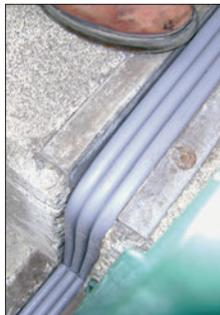
Le système DSM convient singulièrement à la réparation de joints existants et remplace sans peine le calfatage défectueux, les joints à compression ou gonflables, et les mastics de jointement à alvéoles fermées.
