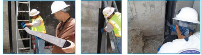
Le SYSTÈME 20H est installé à partir du côté positif (paroi extérieure) du mur de retenue, à l'intérieur d'un joint préformé, après la cure du béton.
