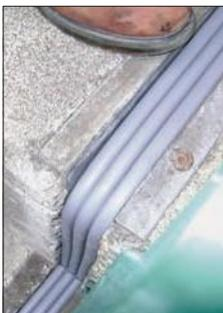
*DSM уникальным образом подходит для переоснащения существующих швов, а также может заменять уплотнители для щелей, холодносварные уплотнители, воздушное уплотнение и герметики.*
