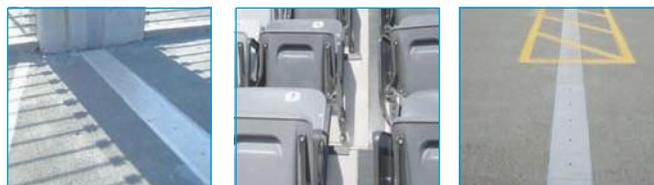
SJS-FR1 и SJS-FR2 представляют собой огнестойкие водонепроницаемые уплотнители для компенсации теплового расширения, устанавливаемые в большие зазоры. Защитная накладка делает их лучшим решением для многоуровневых парковок, стадионов, залов ожидания и концертных залов, полов вне и внутри зданий, а также других мест, где широкие или сейсмические зазоры требуют установки огнестойких, водонепроницаемых, выдерживающих движение транспорта деформационных швов.
