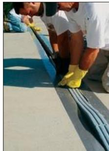
*DSM отличается легкой установкой. После нанесения на основу эпоксидного клея, DSM вталкивается в шов. Примыкающие ленты уплотнителя накладываются на уже установленные и прижимаются сверху некоторое время, пока они не установятся в шве.*
