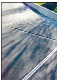
Фиксирующие металлические направляющие (или оси из нержавеющей стали) устраняют смещение сопрягаемых участков. Этот метод оказался успешным. За последние 20 лет были установлены тысячи метров швов MIGUTAN функционирующих до сих пор. Заводские переходники для изменения направления шва обеспечивают цельность уплотнителя.
