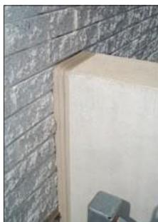
*SEISMIC COLORSEAL является идеальным решением для текстурированных или шероховатых основ. Природная эластичность материала с присущим ему эффектом обратного давления позволяет шву адаптироваться к текстурированной поверхности стены.*
