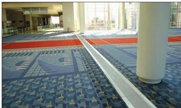
**Система деформационных швов TWINSERT для внутренней отделки**
