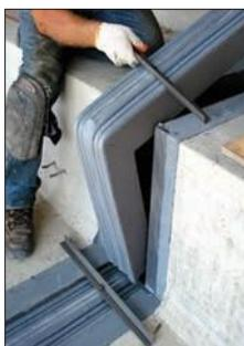
EMSEAL предлагает для ступеней и подступенков готовые заводские переходники, которые облегчают монтаж и обеспечивают водонепроницаемость на участках изменения плоскости шва.
