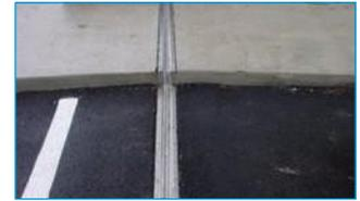
DSM-FP представляет собой гибкий в применении деформационный шов для многослойных плит, а также для соединения многослойных плит с плитами сплошного сечения. В продаже имеются заводские переходники для соединения плиты и стены, бордюров, тротуаров, парапетов, а также Т-образные разветвления и перекрестья для системы DSM-FP.
