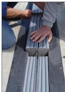
Обратное давление пены SJS и эпоксидного клея обеспечивает водонепроницаемость крепления без анкерных болтов и не требует наличия водослива. Данный шов устанавливается быстрее, чем другие более сложные системы.
