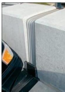
*Продельвание пазов и сгибание пеной подложки позволяет силиконовой кромке гофрированной секции оставаться бесшовной на стыках при смене направления, где всегда трудно обеспечить водостойкость. Чтобы ознакомиться с чертежами различных решений от EMSEAL, обратитесь в EMSEAL по телефону или перейдите по ссылке [www.emseal.com](http://www.emseal.com).*
