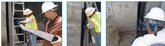
Система 20Н SYSTEM устанавливается с рабочей стороны подпорной стены на предварительно запененное раскрытие шва выдержанного бетона.
