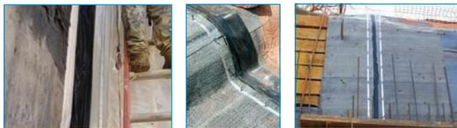
*После установки системы **BG** в бетонное основание или изолирующий слой, бетон заливают, чтобы загерметизировать водостойкую мембрану, что позволяет **BG** стать частью единой водостойкой системы, компенсирующей сдвиги стыкового зазора.*
