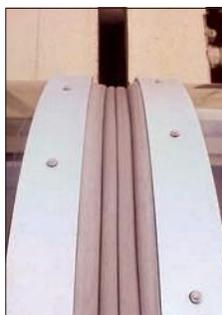
*Крепление без анкерных болтов и уплотнение достигается за счет сочетания реагирующего на давление связывающего акрилового импрегнирования, обратного давления со стороны расширяющейся пены и угловой силиконовой замазки местного применения. Изгибы в элементах здания легко воспроизводятся за счет всенаправленной гибкости материала.*
