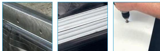
Система SJS-FP состоит из двух узлов. Опоры и боковые гидроизолирующие прокладки устанавливаются на несущую плиту и соединяются с гидроизолирующей системой плиты. Водонепроницаемый предварительно уплотненный материал SJS монтируется между направляющими опоры и закрывается защитной накладкой из алюминия или нержавеющей стали.
