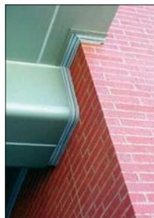
*SEISMIC COLORSEAL, нанесенный на фасад здания между разными материалами, поддерживает R-значение в ограждающей конструкции. Поскольку SEISMIC COLORSEAL не использует механических крепежей, он особенно хорошо подходит для заполнения стыков во внутренних углах.*
