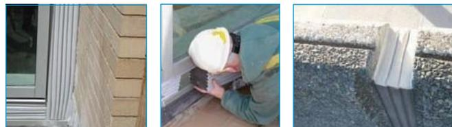
SEISMIC COLORSEAL DS изолирует внутренние и наружные швы несущих стен в один прием. Каждая сторона имеет свой цвет для соответствия цветовой гамме внутренней и внешней поверхности. Для парапетных ограждений данный материал обеспечивает верхнюю, переднюю и заднюю поверхность.
