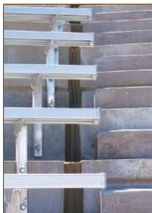
*Водонепроницаемость деформационных швов, используемых на стадионах, на данном рисунке показана на примере зрительских трибун сборного типа. Система DSM обеспечивает целостность уплотнения при перемене плоскости и направления.*
