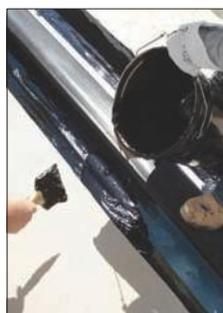
Уплотнительная вставка MIGUTAN и гидроизолирующие прокладки изготовлены из пригодной для горячей сварки термопластической резины. Это обеспечивает цельность уплотнителя при изменении плоскости и направления шва, а также на его концах. Гидроизолирующие прокладки встраиваются между слоями плиты и покрываются водонепроницаемой мембраной. Получается надежное соединение шва и гидроизоляции, которое не разрушается даже при постоянном движении транспорта.
