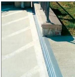
Технология системы DSM SYSTEM предлагает решение для уплотнителей структурных швов. Так, DSM устанавливается в верхней части рампы в месте перехода от наземной части дороги к перекрытию и от стыка «плита-плита» к стыку «плита-стена».
