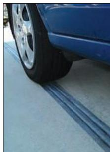
*Система DSM — долговечное решение для высоких транспортных нагрузок на современных многоуровневых парковках. DSM — идеальный выбор при строительстве новых и переоборудовании уже существующих зданий.*
