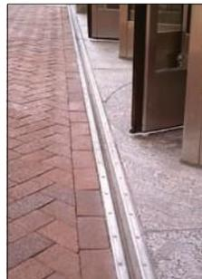
Опоры высотой от 1 дюйма (25 мм) до 12 дюймов (300 мм) позволяют использовать данный шов с брусчаткой, асфальтом, бетоном и другими верхними покрытиями, обеспечивая исключительно долгий срок службы шва при движении транспорта и суровых погодных условиях.
