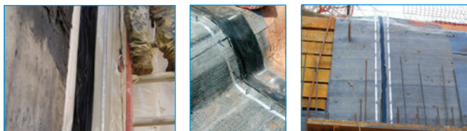
Une fois le système BG installé dans le coulis de béton ou le blindage de bois, le béton est coulé pour envelopper la membrane d'étanchéisation et le joint BG de manière à former un système étanche capable de s'ajuster aux mouvements à l'ouverture du joint.
