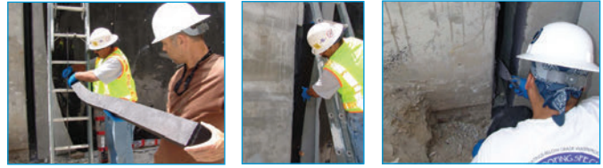
Le SYSTÈME 20H est installé à partir du côté positif (paroi extérieure) du mur de retenue, à l'intérieur d'un joint préformé, après la cure du béton.
